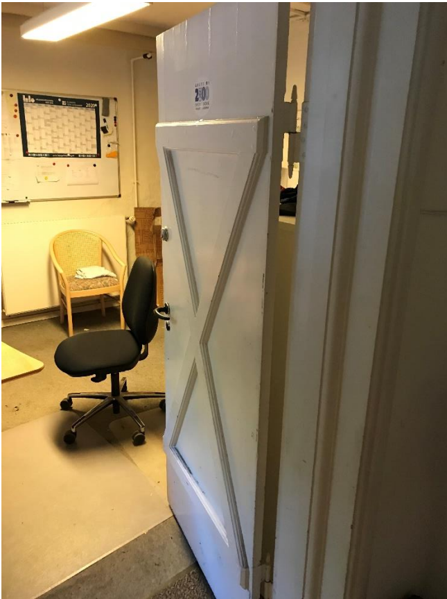
Figur 4: Manglende brandteknisk klassifikation af dør
