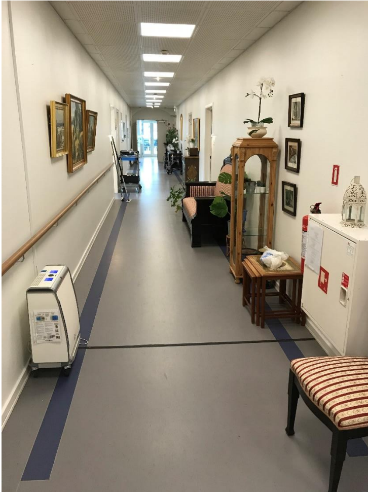
Figur 10: Manglende opdeling af flugtvejsgang pr. 25 m med en røgtæt dør (6.11.2 stk. 2) samt manglende friholdelse af den nødvendige fribredde af flugtvejsgang på 2.4 m jf. 6.11.4 stk. 2. Samtidig er brandbelastning i flugtvejsgange større end foreskrevet. (6.5.1 stk. 3)
